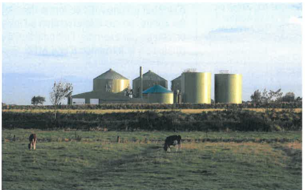
Installation de méthanisation à la ferme à Lohe-Rickelshof, Land du Holstein, Allemagne, photo par Dirk Ingo Franke, 2009 (CC)
