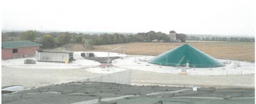
Installation de méthanisation agricole avec système « tank in tank » (post digesteur imbriqué dans le digesteur) enterré. Source : Biogas Hochreiter GmbH - A.E.B. - Méthafrance.
