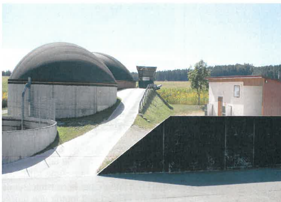
Installation de méthanisation agricole. Source agriKomp.
