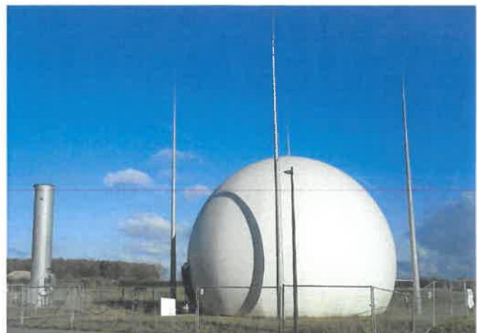
Réservoir souple de stockage de biogaz et sa torchère, photo Alex Marshall 2007 (CC)
